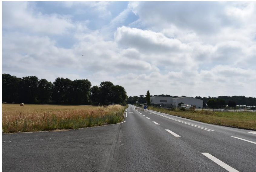
Vue sur la RD 19 (direction Candé) depuis l'accès au futur site Manitou
