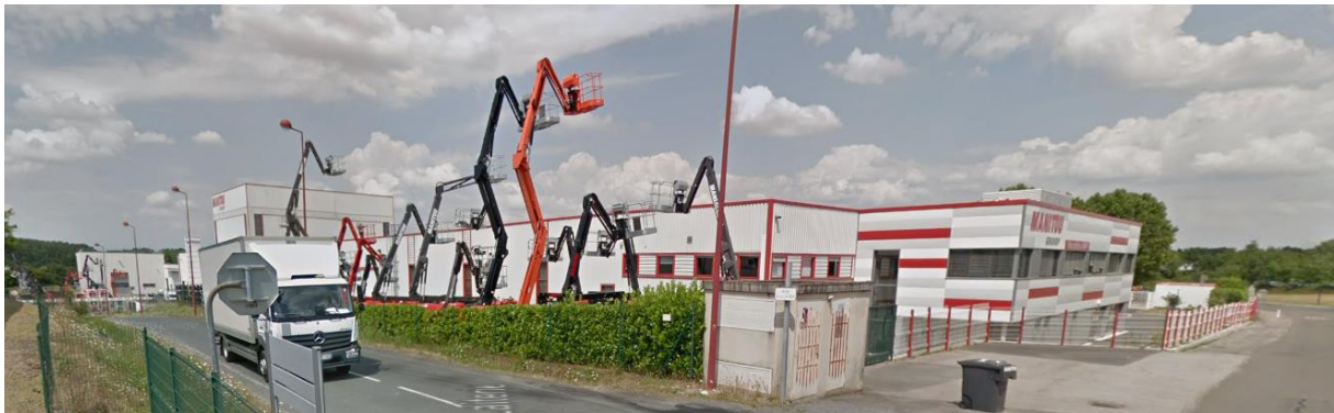
Occupation du site Manitou / Croisement route de Challain – rue de la Laiterie
