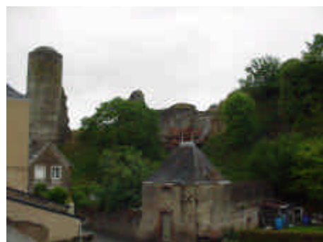
Traces apparentes des fortifications du château
