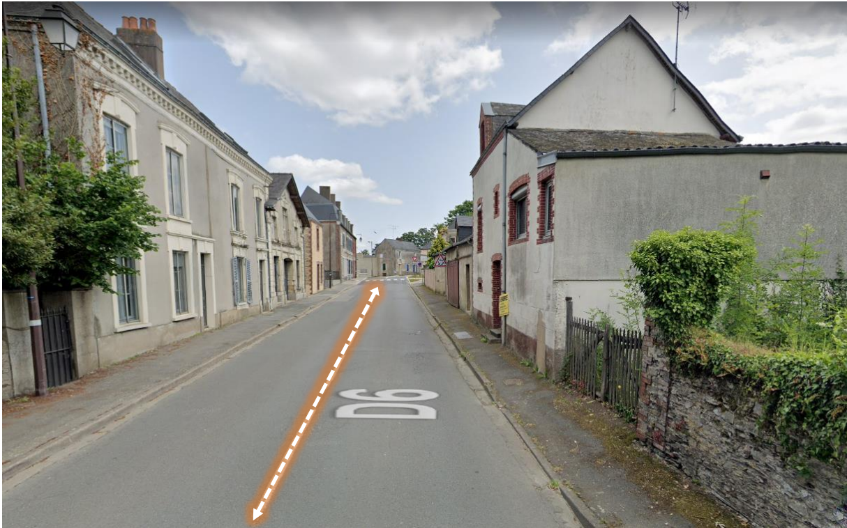
Boulevard du Vieux Château : PAA – PVC autorisé (sous réserve de teintes définies dans le règlement) pour les menuiseries au Nord (gauche sur la photo – PA) – PVC interdit au Sud (droite) sur la photo avant modification n°1 de la ZPPAUP
