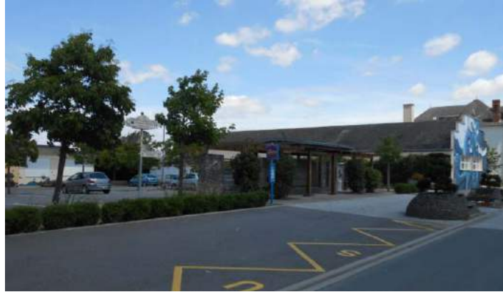
Un point d'arrêt en centre bourg qui s'accompagne d'une offre de stationnement qui en fait un véritable point multimodal
