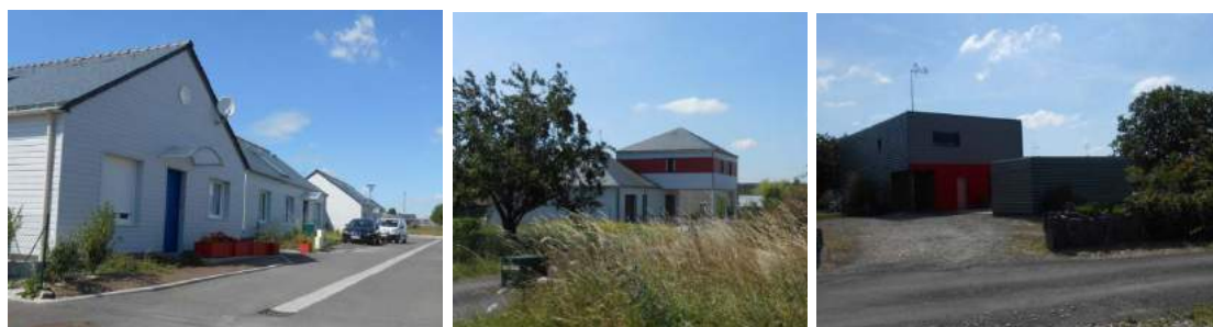
Constructions les plus récentes (lotissement de l'Alexandrière et Misengrain)
