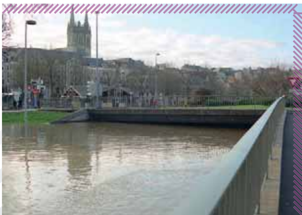
INONDATION DES VOIES DES BERGES À ANGERS EN 1995
